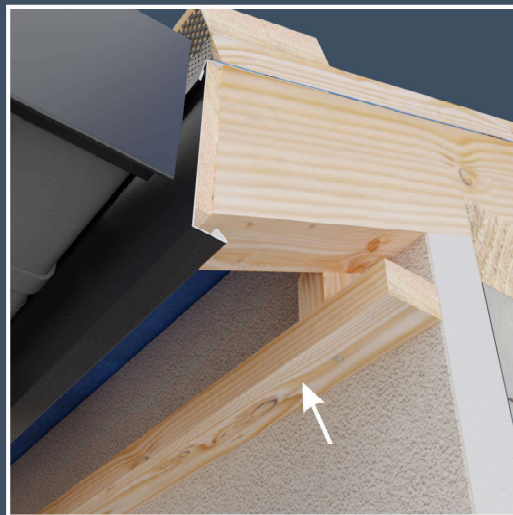
Montage des Befestigungsrahmens für die Laibung.
