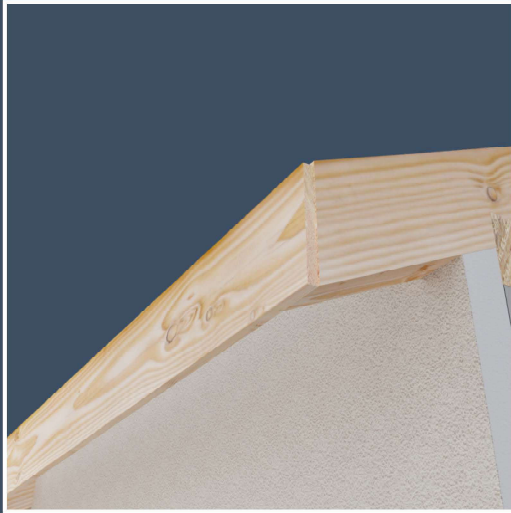
Dachabnahme und Vorbereitung für die Verlegung des Dachrinnensystems und deren Dacheindeckung.
